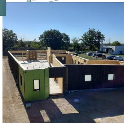
**SYFACE a participé à la construction d'une crèche inter-entreprises de 30 berceaux en réalisant : les façades ossature bois, les menuiseries extérieures et brise-soleil orientables et les caissons de toiture en bois.**
