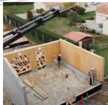
SYFACE a réalisé la fourniture et pose des façades à ossature bois avec menuiseries extérieures PVC et volets roulants aluminium posés en usine de 30 logements individuels d'une résidence sénior.
