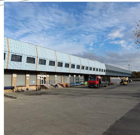
**SYFACE a rénové les façades des bureaux de ce bâtiment logistique en fournissant et en posant des surfaçades ossature bois avec menuiseries extérieures acier, traitement sous-face bureaux et habillages intérieurs bois.**
