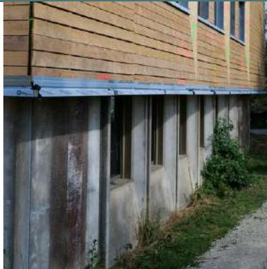
En groupement avec l'entreprise RAIMOND, SYFACE participe au "Macro-lot Clos & couvert" de la rénovation et l'extension du collège Molière. SYface réalise, en site occupé, la fourniture et pose des façades à ossature bois avec menuiseries et volets roulants aluminium posés en usine.
